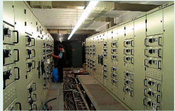
⑥ Ersatz der älteren Schaltanlage (Hintergrund) durch den neuen Typ ▶
