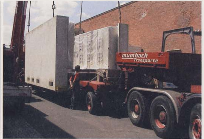
Bild 6: Transport der Betongebäude mit den Schaltanlagen
