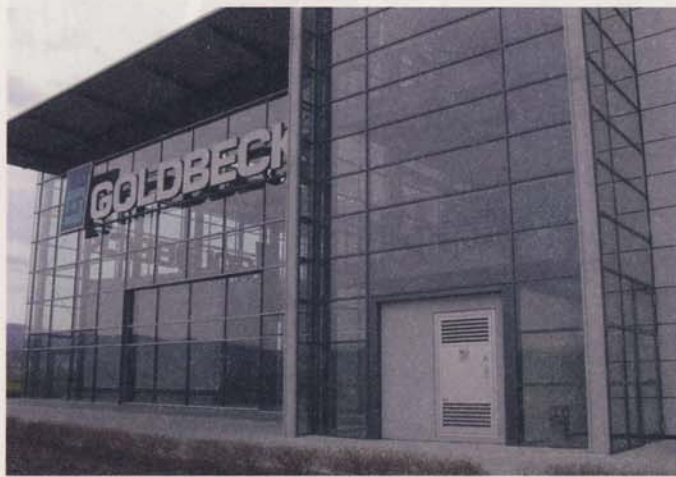
Bild 5: Störlichtbogengeprüfte Fertigstation in einem Gebäude
