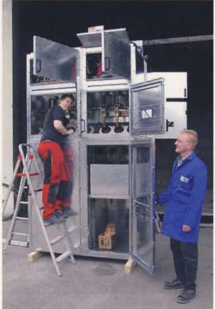
Bild 2. Errichtung der zu prüfenden Schaltfelder
