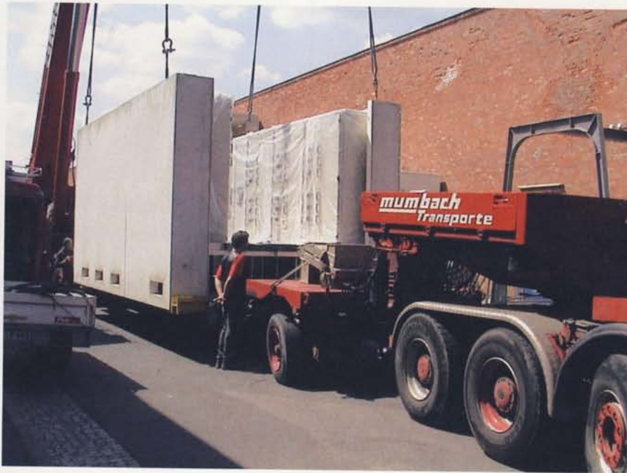
Bild 3. Transport der Betongebäude mit den Schaltanlagen
