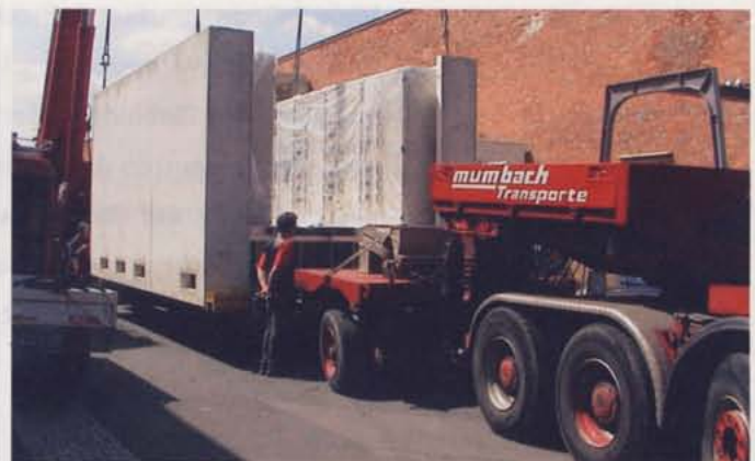
Bild 3: Transport der Betongebäude mitsamt der Schaltanlagen
