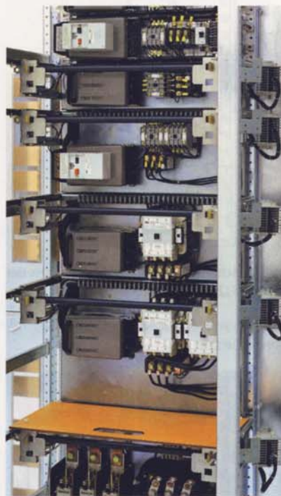
Abb. 1. Schubeinsätze der zweiten Generation, Baujahr 1990
