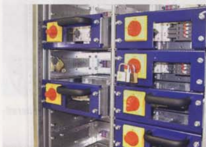
Abb. 4. Verschiedene Positionen der Schubeinsätze, rechts: Betriebs- und Prüfstellung, links: Trenn- und Absetzstellung
