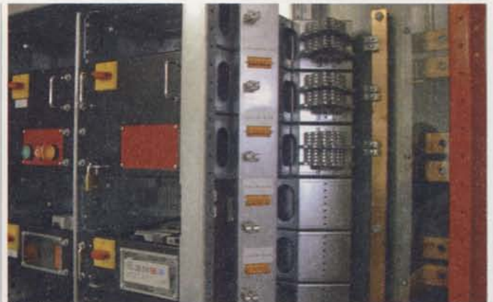
Anschluss der Module für Profibus DP über den Mehrfach-Feldbusverteiler im Kabelanschlußraum
